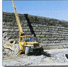
Укрепление склонов
