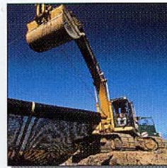
Земляные работы и сооружение фундаментов
