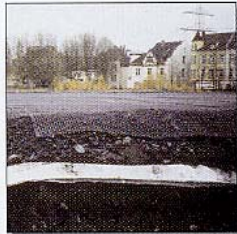
Восстановление территорий после сноса зданий
