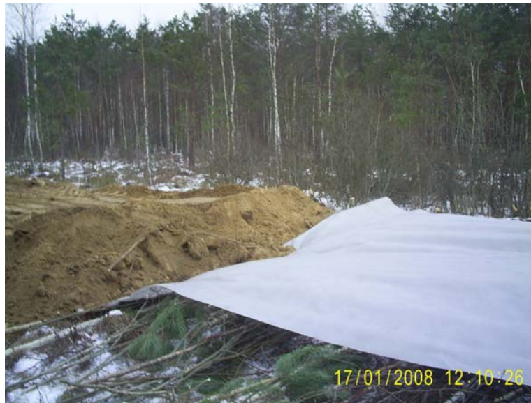
Рис. 5 - Строительство опытного участка в Осиповичском лесхозе
