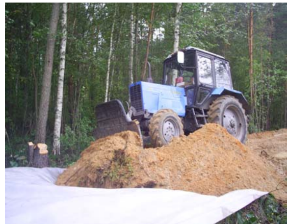
Рис. 6. Строительство опытных участков в Кличевском лесхозе а- отсыпка земляного полотна лесной дороги; б- разравнивание слоя земляного полотна
