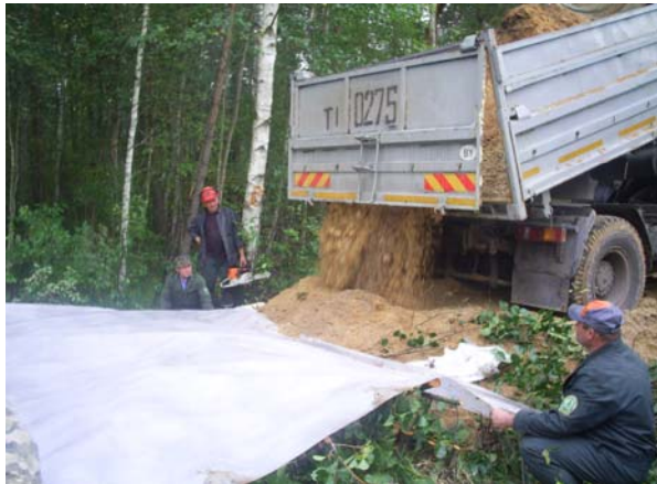
Рис. 6. Строительство опытных участков в Кличевском лесхозе а- отсыпка земляного полотна лесной дороги; б- разравнивание слоя земляного полотна
