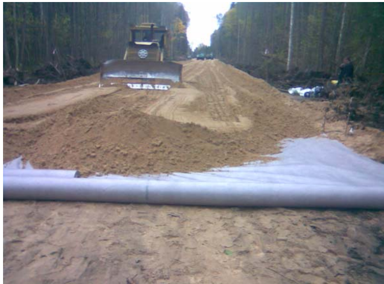
Рис. 2. Строительство опытного участка в Быховском лесхозе
