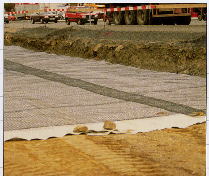
Армирование георешеткой Fornit® Ланглад Кonti, Висконсин / США
